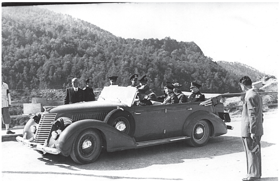
Il re arriva a Collepiano (Pietracamela), in visita agli impianti in costruzione, accolto dall'ing. Francesco Bronzini e Giuseppe Albera, direttore dei lavori.
