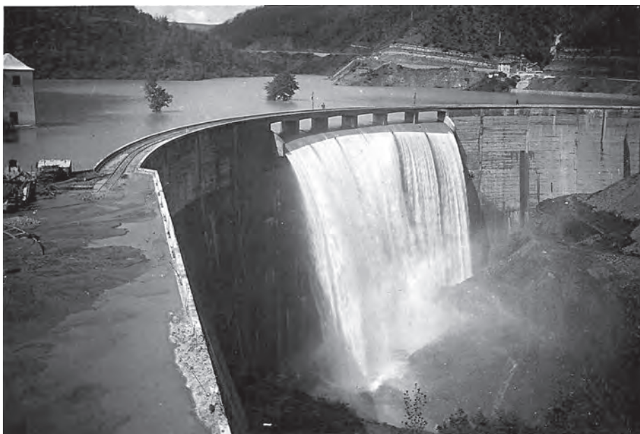
Diga di Provvidenza in costruzione
